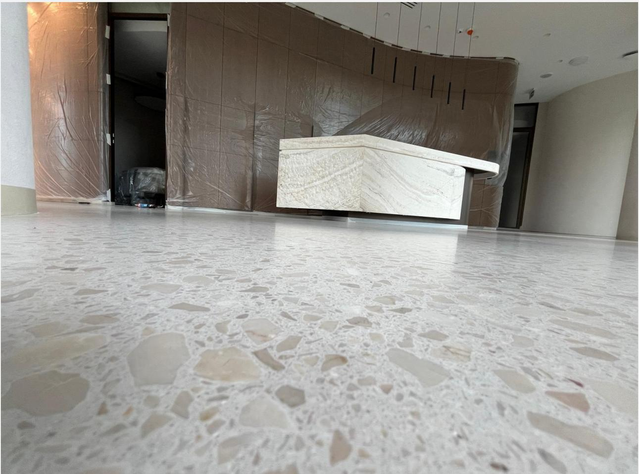
Le Terrazzo Ducale S.l. permet de réaliser des semis et des terrasses même à faible épaisseur en utilisant la magnésite comme liant naturel qui remplace, en dépassant les limites, la chaux et les produits cimentaires ou à base de résine.
