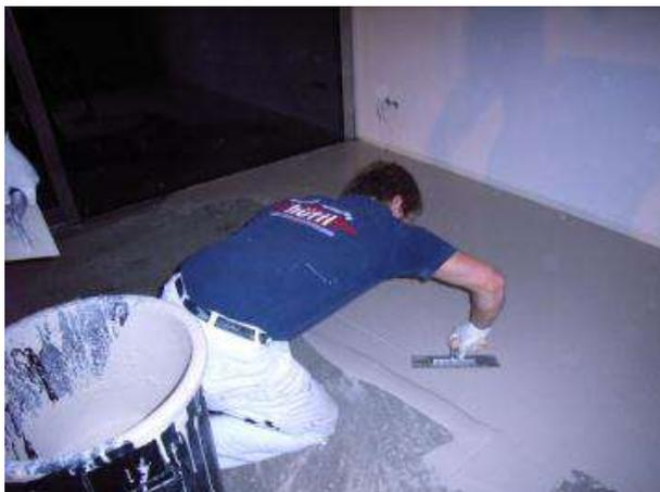
Le lendemain (la surface doit être assez dur pour permettre la marche avec des chaussures à clou sans laisser de trous) appliquer une couche de PRIMER INTERMEDIO dilué avec de l'eau dans le rapport 1:4. La consommation approximative est de 100 gr. / m<sup>2</sup>.
