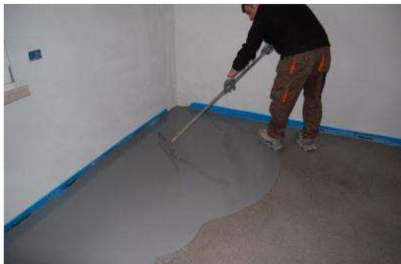
Un deuxième opérateur, aussi avec des chaussures à clou, complètera le nivellement du produit avec une spatule à anses plates. Cette procédure est également utilisée pour créer le «mouvement» des nuances de la surface et pour supprimer toute structure potentielle laissée par le rouleau à pointes.
